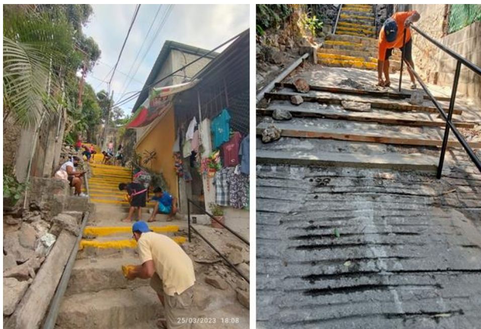
Foto 15. Seguimiento de pintar escaleras y rehabilitación de rampa. Fuente: Ramírez, 2023.
