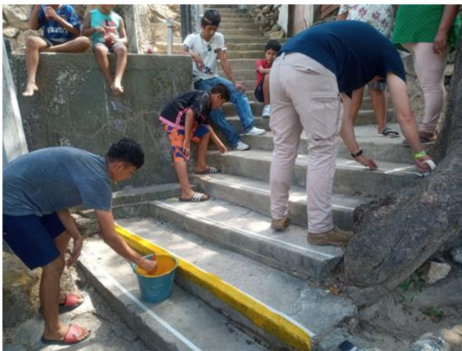
Foto 13. Escaleras de seguridad.
