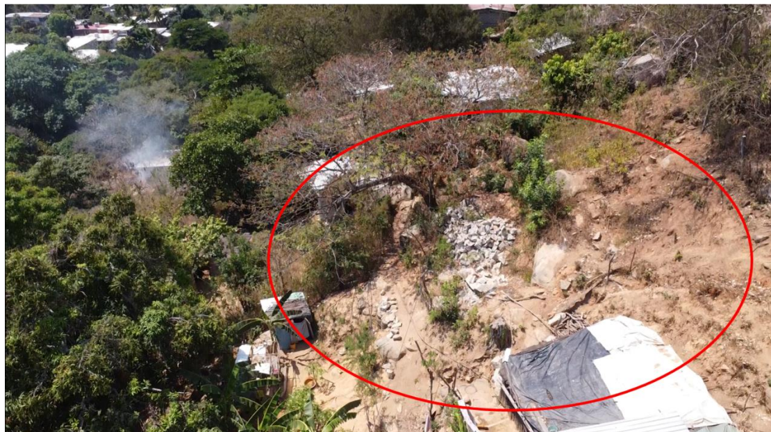
Foto 21. Riesgo por derrumbe.
