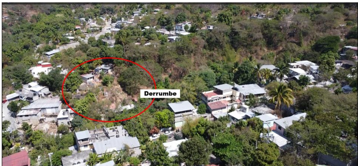
Foto 22. Riesgo por derrumbe.
