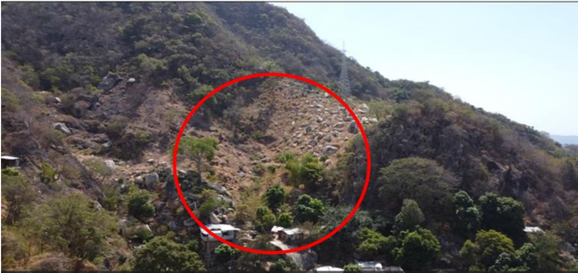
Foto 23. Riesgo por caída de bloques
