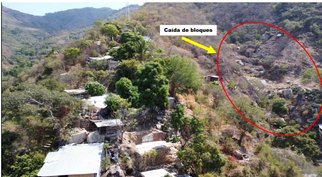
Foto 24. Riesgo por caída de bloques a viviendas.
