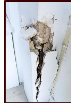
**CASO I:** El acero aún no ha disminuido la sección, la reparación consiste en dar tratamiento al acero, el daño es leve.
